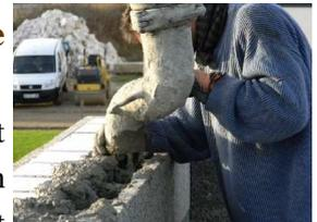
La solution : le système Thermibloc®. Le Thermibloc® est un bloc de «béton de bois» (Matériau 100% recyclable), qui construit et isole en même temps des logements ou bâtiments collectifs de plusieurs niveaux.
