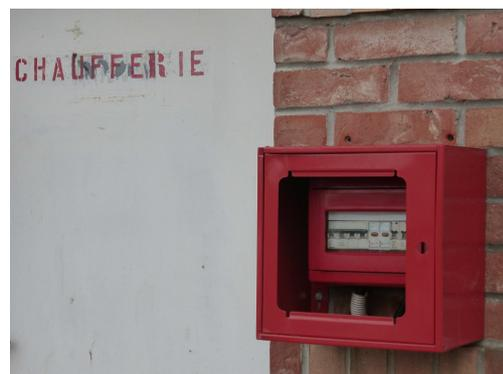
Le remplacement du coffret de coupure électrique de la chaufferie de l'école B.Degunst a été remplacé suite à sa détérioration.
